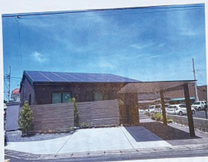
「LUX エクステリアコンテスト 2024」のファサード部門入賞作品。 「カーポート SC の天井と木調タイプを採用しました。個性の強いシンプルなデザインの住宅だったの で、印象的な玄関のウッド調のドアをポイントにして、それにカーポート SC の木調タイプを合わせてい ます。また、目隠し壁にするところを天然木のフェンスを使って連続させることでデザイン的に流れが良 くなり、この平屋住宅の全体の輪郭が出て綺麗に見えるようになってデザインしました。」(松井社長)
